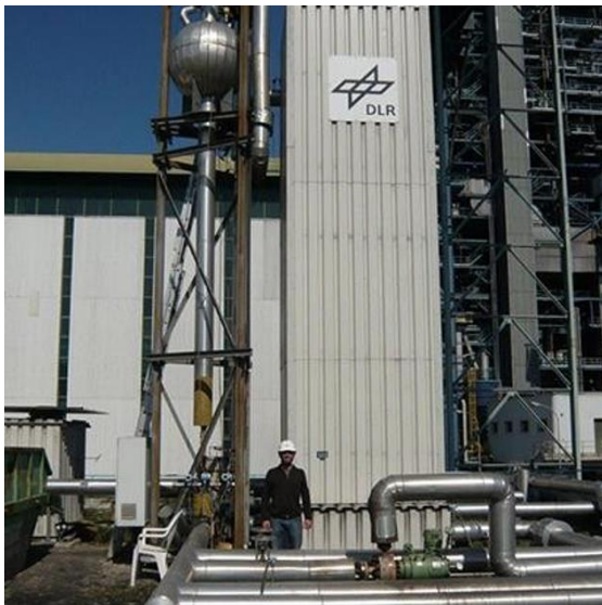
Abbildung 1 Latentspeichermodule mit 700 kW Leistung, Speicherkapazität 1h. \text{NaNO}_3 als Speichermaterial, Phasenwechsel bei 305 °C
