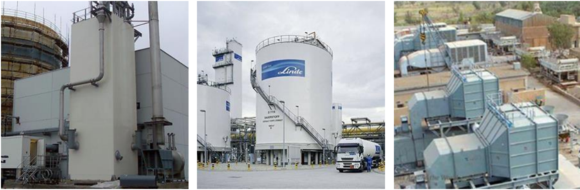
Abbildung 2 v.l.n.r. Verflüssiger; Kryogener Flüssigkeitstank für 350 MWhel; Heißgas-Expander
