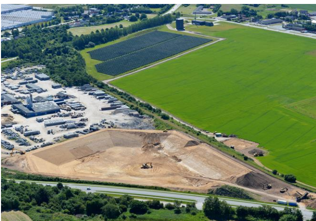
Abbildung 2: Erbeckenspeicher Meldorf (Bildmaterial: Ramboll)
