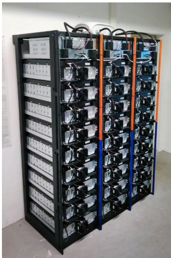
Abbildung 4: Batteriesystem bzw. Batterie; Zusammensetzung von Batteriepacks oder Modulen, die eine funktionsfähige Einheit darstellen, in einem Gehäuse.
