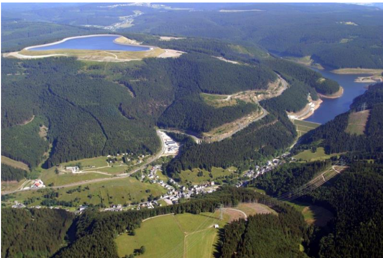
PSW Goldisthal: Ober- und Unterbecken (Quelle: Vattenfall)
