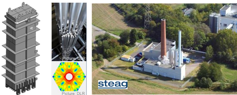
Abbildung: Phasenwechselspeicher (links: Aufbau) im STEAG-Kraftwerk Wellesweiler (rechts)
