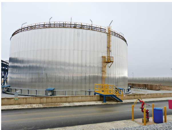
Abb. 1. Foto eines Flüssigsalztanks (links) und Verschaltungsprinzip im solarthermischen Kraftwerk (rechts).
