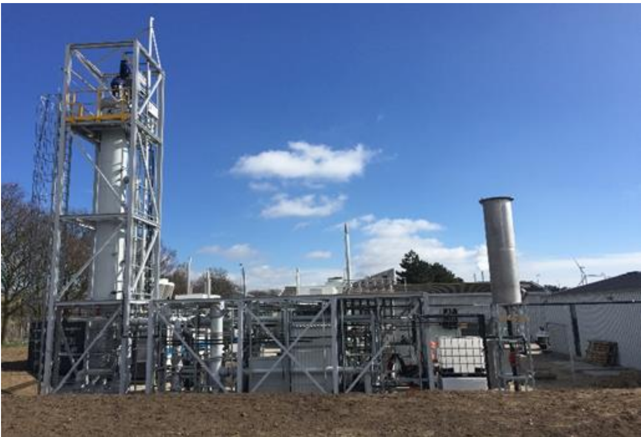
Abbildung 3: Power-to-Gas mit biologischer Methanisierung in Kopenhagen (Avadøre), Dänemark
