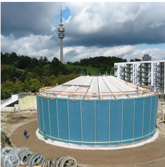
Abbildung 3: Vom ZAE Bayern entwickelter (BMU gefördertes Projekt 0329607G) saisonaler Nahwärmespeicher (6000 m 3 ). Ladung durch Solarwärme mit 48% Deckungsgrad (3000 m 2 Kollektoren).
