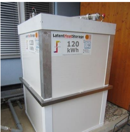
Abbildung 4: Latentwärmespeicher zur Rückkühlung einer Absorptionskälteanlage zur solaren Klimatisierung (links); am Wärmetauscher kristallisierendes PCM während der Entladung des Speichers (rechts)
