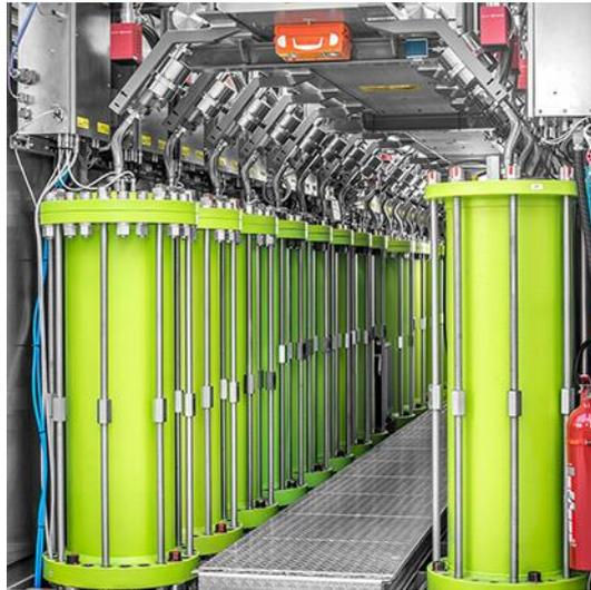
Abbildung 3: Innenraum des Schwungrad-Energiespeichers der Firma STORNETIC
