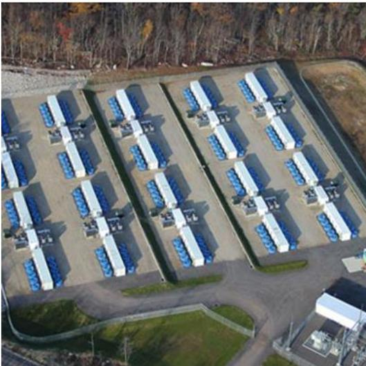
Abbildung 4: 20MW Speicher zur Frequenzregulierung in Pennsylvania, USA (Beacon Power)
