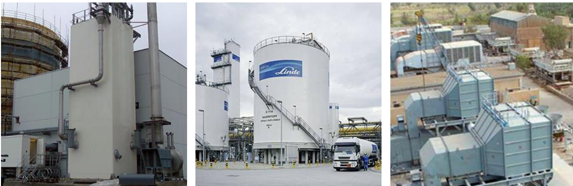
Abbildung 2 v.l.n.r.: Verflüssiger; Kryogener Flüssigkeitstank für 350 MWh el ; Heißgas-Expander
