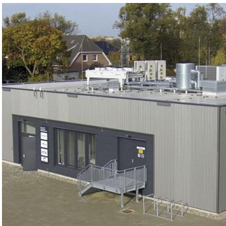
Abb. 4: WEMAG-Speicher, 5 MW / 5 MWh, nimmt am Primärregelenergiemarkt teil, erster kommerzieller Batteriespeicher in Europa, Standort Schwerin; Bildquelle: Younicos AG
